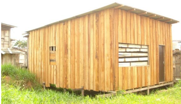
Fonte: DESO/SEHAB/2013 Evento: Visita em construções irregulares Período: Março/2013
