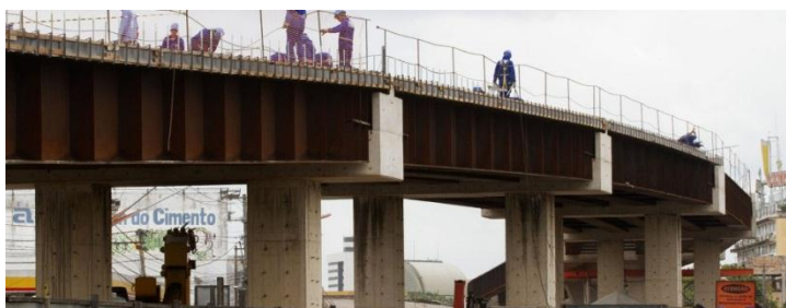
Construção do elevado do Entroncamento – BRT.
