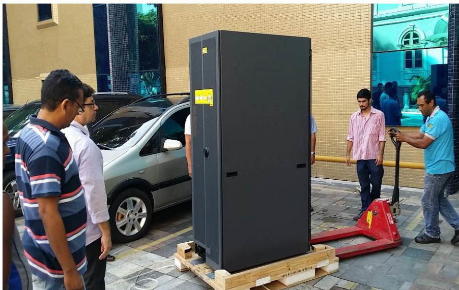
Figura 127. Entrega do novo Datacenter na sede da CINBESA.
