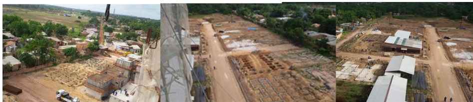
Figura 99. Canteiro de obras do Viver Primavera
