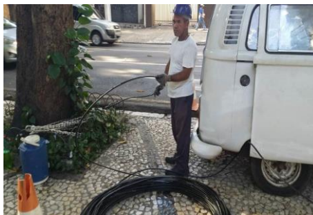
Figura 126. Instalação da rede de fibra ótica
